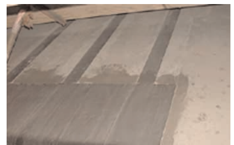
Abb. 8a, b: Verankerung der angeklebten Querkraft- und Torsionsbewehrung bei der Verstärkung der West Gate Bridge
