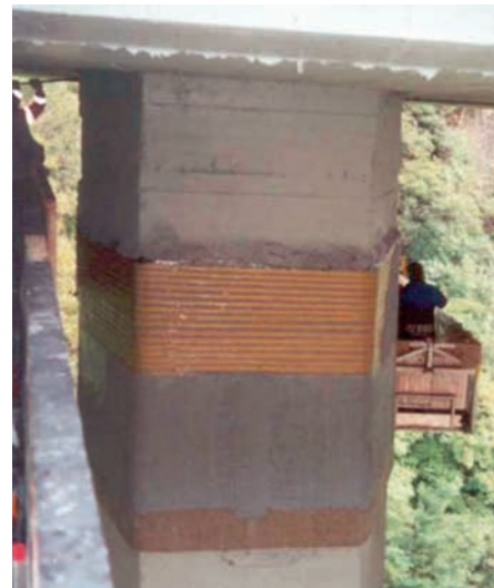
Abb. 10: Umschnürung eines Brückenpfeilers der Brennerautobahn mit vorgespannten Aramidbändern
