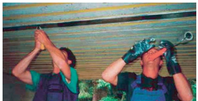
Abb. 3: CFK-Lamellen für die Biegezugverstärkung von Massivbrücken
