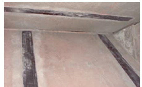
Abb. 8a, b: Verankerung der angeklebten Querkraft- und Torsionsbewehrung bei der Verstärkung der West Gate Bridge
