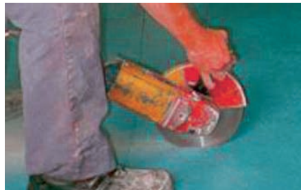
Abb 4: Einschlitzen der Betonoberfläche
