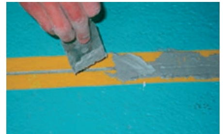
Abb 5: Auftragen des Klebers
