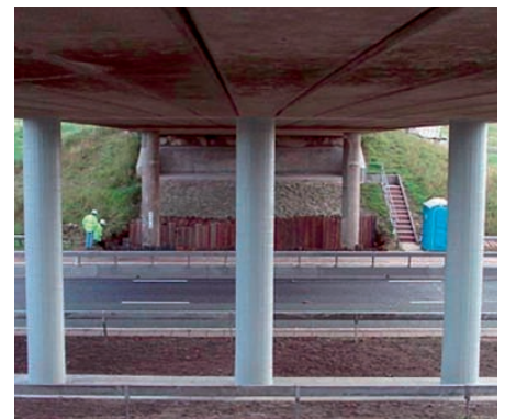
Abb. 11a, b: Umschnürung von Brückenpiellern mit FRP zur Verstärkung gegen Anpralllasten
