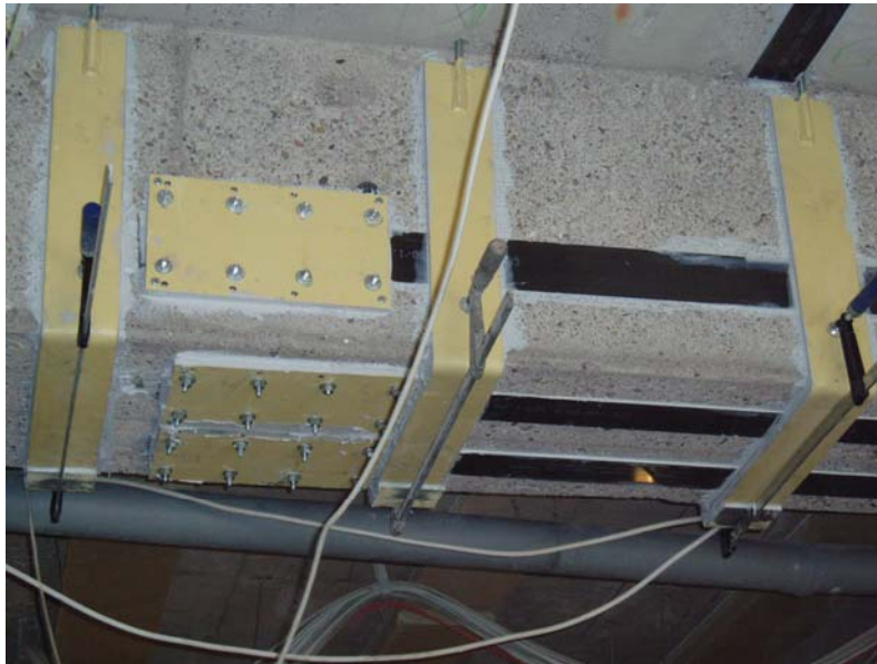
Bild 3. Verankerungsplatten und Stahllaschenbügel am Unterzug
