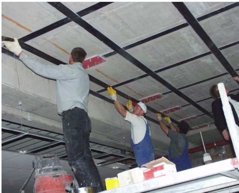
Bild 2. Ausführung der Verstärkungsmaßnahme
