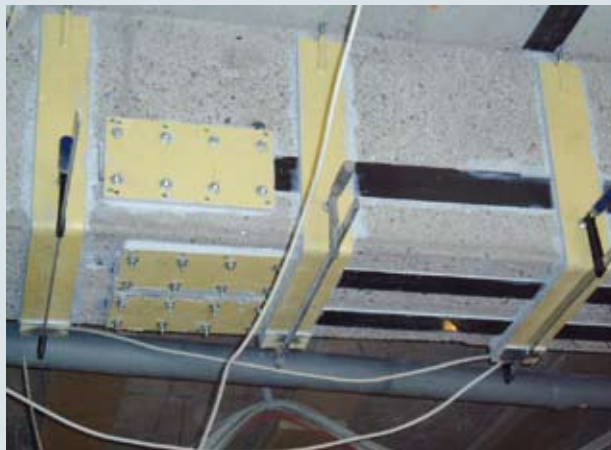
▲ Bild 10: Verstärkung eines Unterzugs mit vorgespannten CFK-Lamellen
