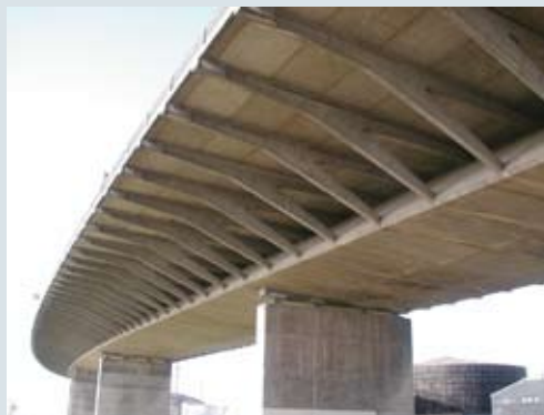
▲ Bild 8: Untersicht des Spannbeton-Brückenüberbaus vor der Verstärkung
