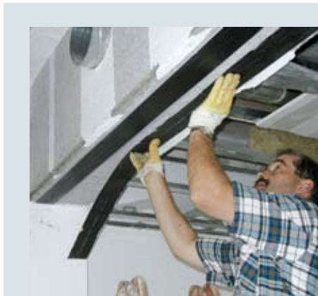
◀ Bild 3: Aufkleben vorgefertigter CFK-Lamellen auf die Bauteiloberfläche
