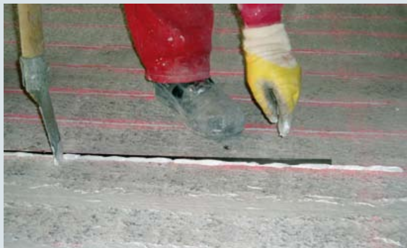
Bild 4: Einkleben von vorgefertigten CFK-Lamellen in Betonschlitzten ▼
