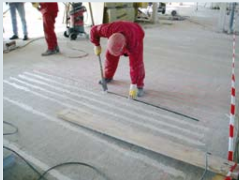
▲ Bild 7: Oberseitige Deckenverstärkung mit in Schlitze eingeklebten CFK-Lamellen
