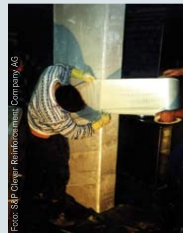
▲ Bild 2: Handlamination von FRP-Sheets
