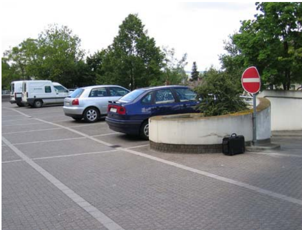
Bild 2: Dachdecke der Tiefgarage (Freideck)
