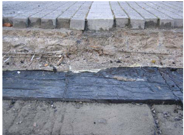
Bild 3: Deckenaufbau des Freidecks, Detail
