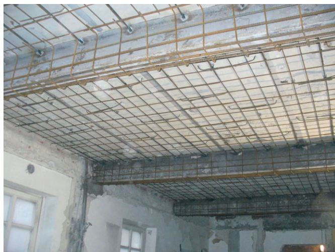
Bild 4. Zusatzbewehrung an Decke und Unterzügen in den Obergeschossen (Foto: Torkret AG)
