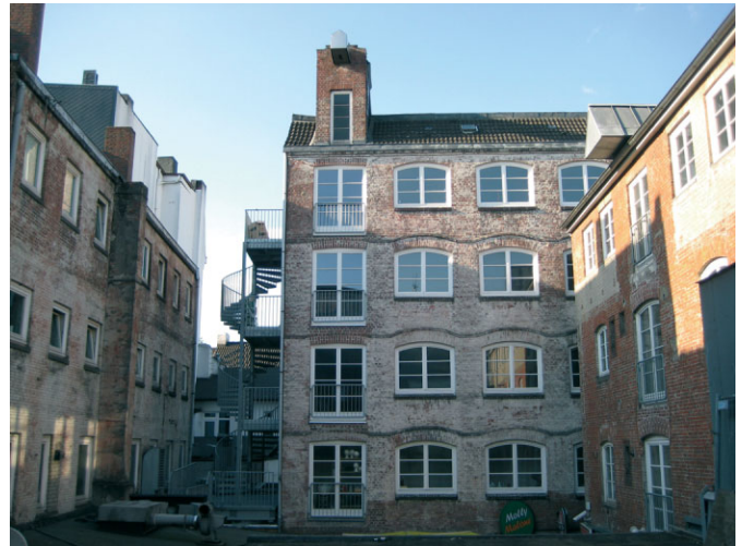
Bild 1. Außenansicht des ehemaligen Lagerhauses
