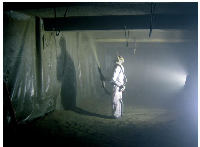
Bild 3. Ausführung der unterseitigen Spritzbetonverstärkung
