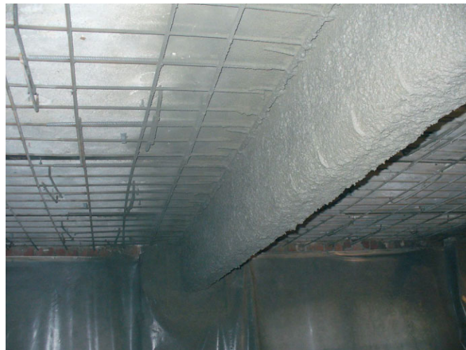
Bild 7. Unterzug während der Ausführung des Spritzbetons (Foto: Torkret AG)
