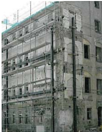
Bild 8. Fassadenaussteifung mit Stahlprofilen
