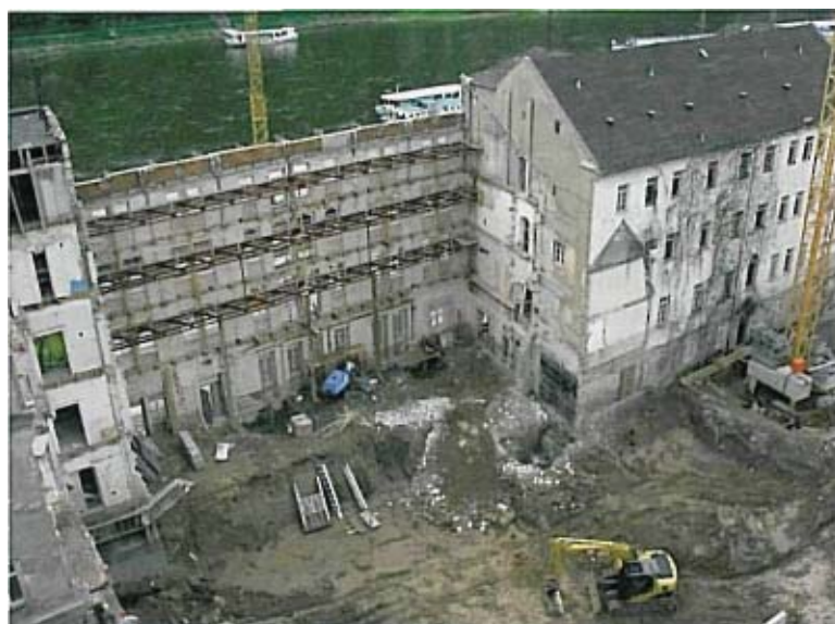
Bild 9. Aussteifung der elbseitigen Fassade mit Fachwerkträgern
