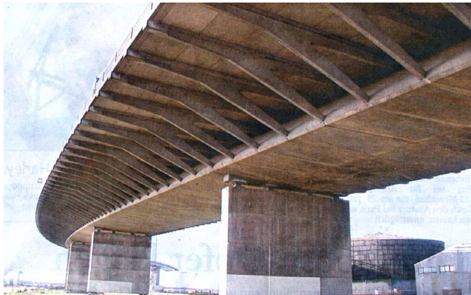
Innovative Technologie aus Braunschweig für Melbourne: Das Ingenieurbüro bow stabilisiert die Unterseite der West-Gate-Bridge mit superleichten Kohlefaserlamellen. Ein Abriss oder teurer Neubau erübrigt sich. Foto: bow
