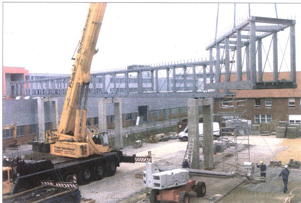
Aus Stahl-Fachwerkträgern entsteht derzeit das Gerüst für den Glasgang zwischen den Bürogebäuden.
