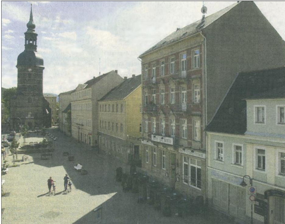
Noch bietet die Südseite des Bad Schandauer Marktes außer dem Hotel „Krone“ (rechts) einen traurigen Anblick. Die Gebäude stehen leer, verfallen. Mit dem Hotelkomplex „Elbresidenz“ soll sich das künftig ändern. Foto: SZ/Dirk Zschiedrich
