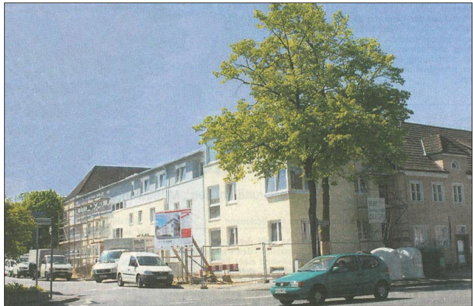
Angrenzend an eine der so genannten Höfe-Häuserzeilen (rechts) entsteht in Innenstadt-Randlage am Wellekamp ein Komplex mit zehn Eigentumswohnungen. Fotos (2): Bernward Comes
