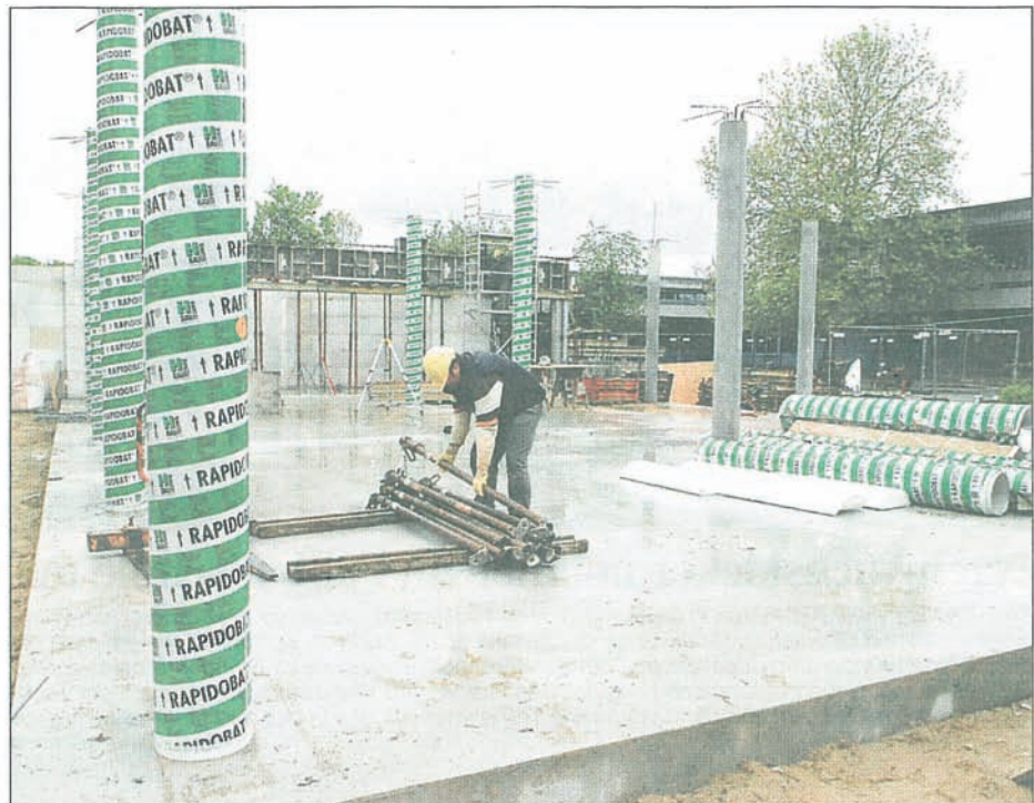
Auf 500 Quadratmetern Grundfläche entsteht die Mensa am Ernestinum.
