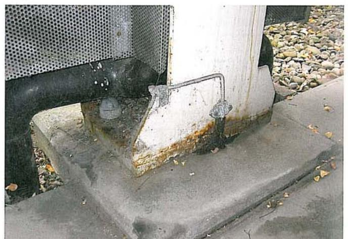
Bild 5. Korrosionsschäden an den Stahlbauteilen
