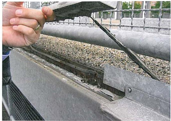
Bild 6. Beschädigte Beschichtung und Rissbildung in der Bodenplatte
