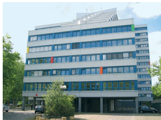
Bild 2. Freideck der Tiefgarage (Ebene 0) und aufgehenes Gebäude
