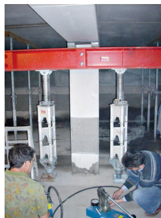
Bild 3. Abfangung des Hochhauses in Tiefebene –1
