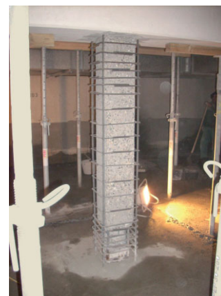
Bild 4. Spritzbetonverstärkung in Tiefebene –1 (Bilder: bow ingenieure gmbh)
