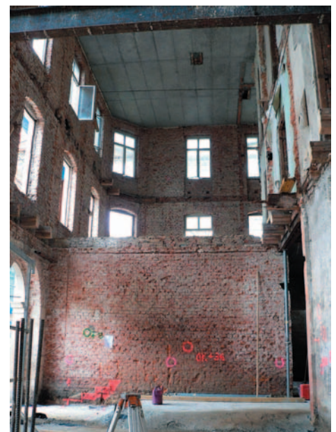
Bild 7: Austausch der Geschossdecken im Gebäude „Dampfschiff“
