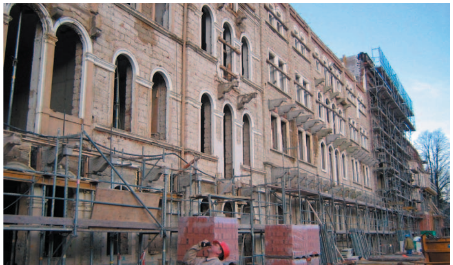
Bild 9: neue Stahlbeton-Balkonkonsolen nach dem Vorbild bestehender Sandstein-Konsolen
