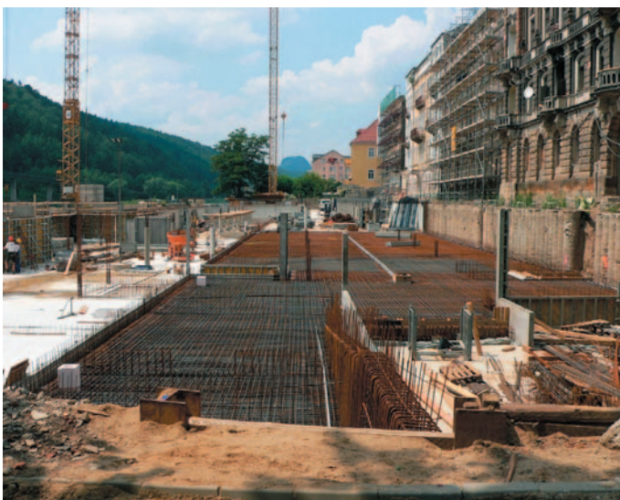
Bild 6: Baugrube der Tiefgarage mit Bohrpfehlwand
