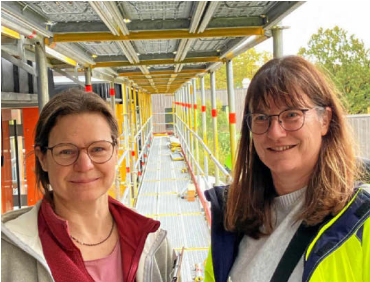
Silke Pfeiffer (rechts) und Sandra Wöhrer, Projektleiterinnen beim Hochbau, führten über den Rohbau.
