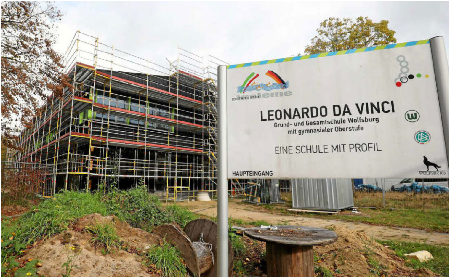
An der Franz-Marc-Straße in der Kreuzheide entsteht derzeit ein neues Gebäude für die Leonardo-da-Vinci-Schule.
