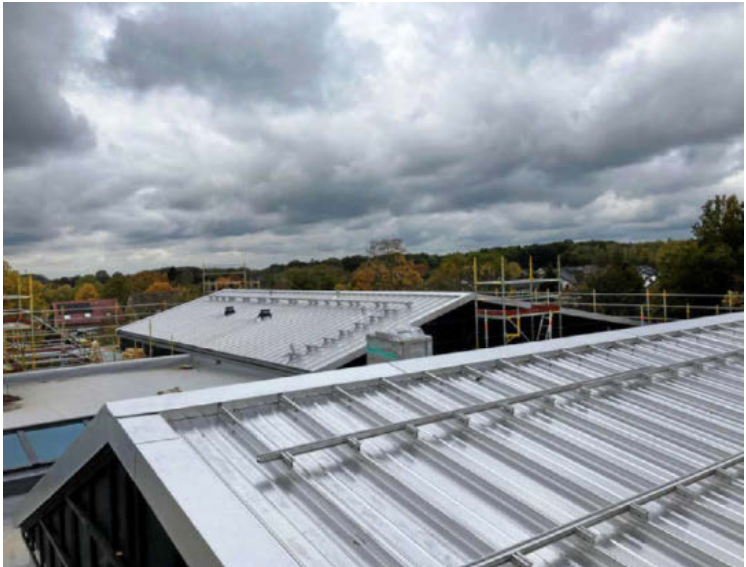
Aufs Dach bekommt die Grundschule Leonardo da Vinci Photovoltaik.
